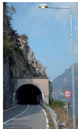
Figura 30 - Palo passivo su ex SS 469 (prov. BG)
