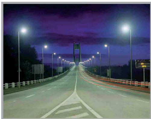
Figura 8 - Accesso ad un ponte (foto Philips)
