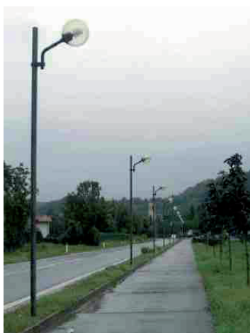
Figura 52 - Esempio di illuminazione stradale da evitare
